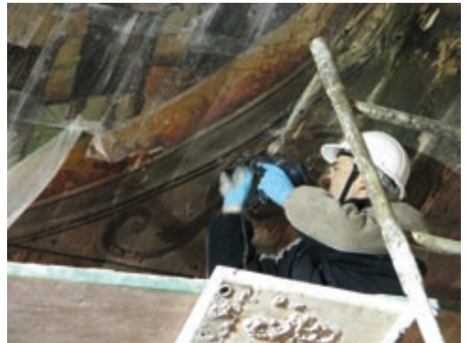
Kościół pw. św. Szymona i Judy Tadeusza w Gnojewie. Wstępna konsolidacja malowideł stropu z 1717 r.
