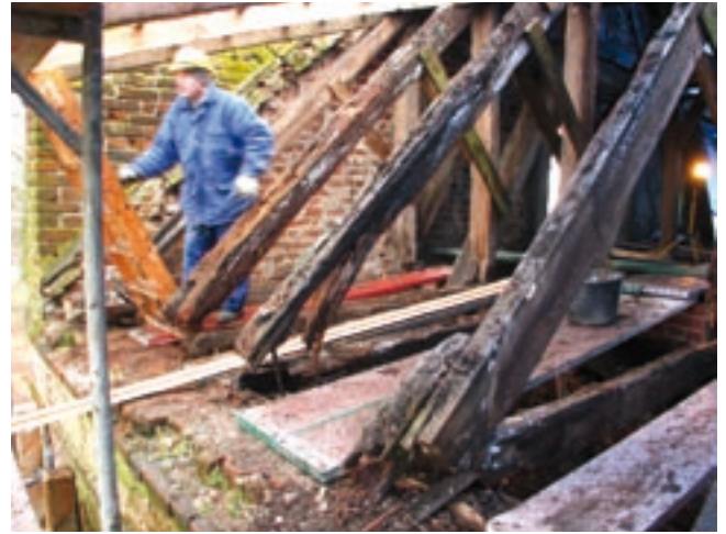
Kościół pw. św. Szymona i Judy Tadeusza w Gnojewie. Zniszczenia więźby. Krokwie nad nawą północną.
