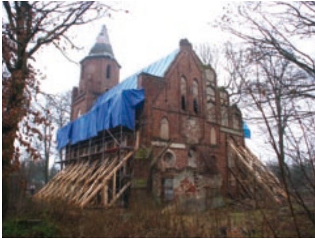
Kościół pw. św. Szymona i Judy Tadeusza w Gnojewie. Zabezpieczenie ścian kościoła.
