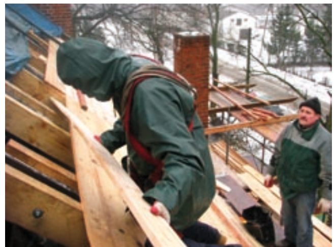
Montaż nowego deskowania na wzmocnionych krokwiach
