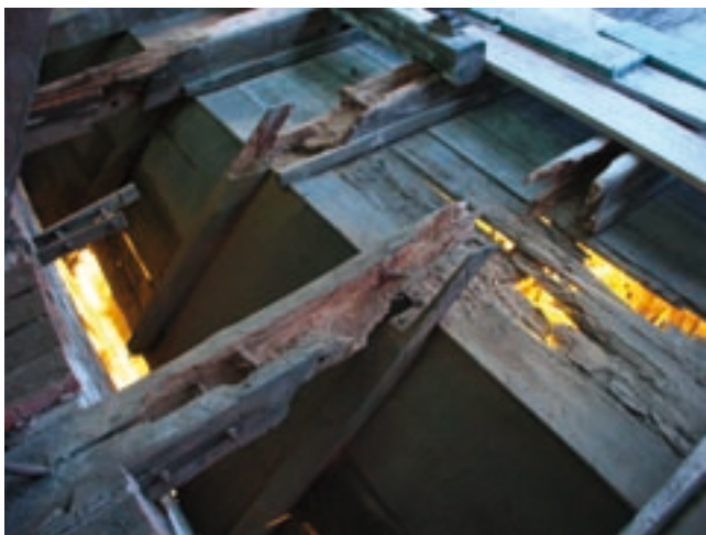
Kościół pw. św. Szymona i Judy Tadeusza w Gnojewie. Belki więzarowe po oczyszczeniu. Widoczny stopień zniszczenia barokowego stropu.
