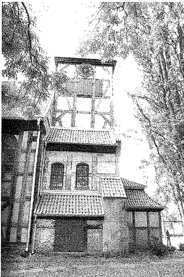
Fot. 5 . Widok na wschodnią część dzwonnicy kościoła
