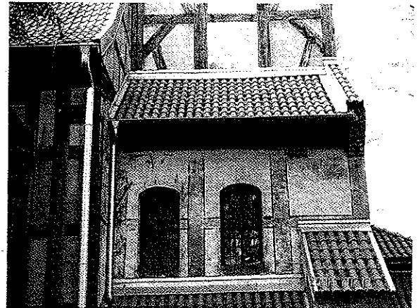
ZDJĘCIE NR 27 Agresywne opierzenia blacharskie nie pasują charakterem do bryły kościoła. Zastąpienie dachówki na przykryciu szkarpy gzymsem kapnikowym także zabezpieczy przed szkodliwym działaniem deszczu.
