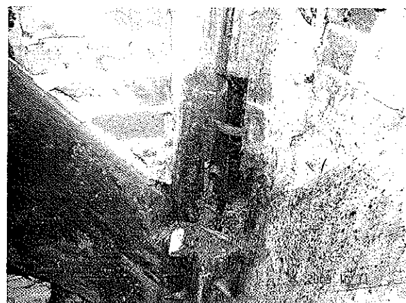
ZDJĘCIE NR 11 Uszkodzony słup w narożniku północno-zachodnim wieży widziany od zewnątrz i od strony wewnętrznej.
