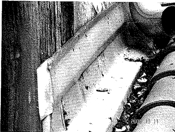
ZDJĘCIE NR 27 Agresywne opierzenia blacharskie nie pasują charakterem do bryły kościoła. Zastąpienie dachówki na przykryciu szkarpy gzymsem kapnikowym także zabezpieczy przed szkodliwym działaniem deszczu.
