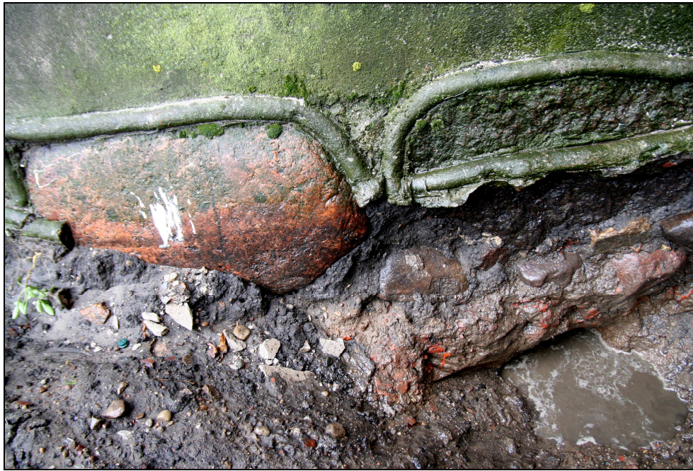
Odkrywka nr 3 zdjęcie nr 4
