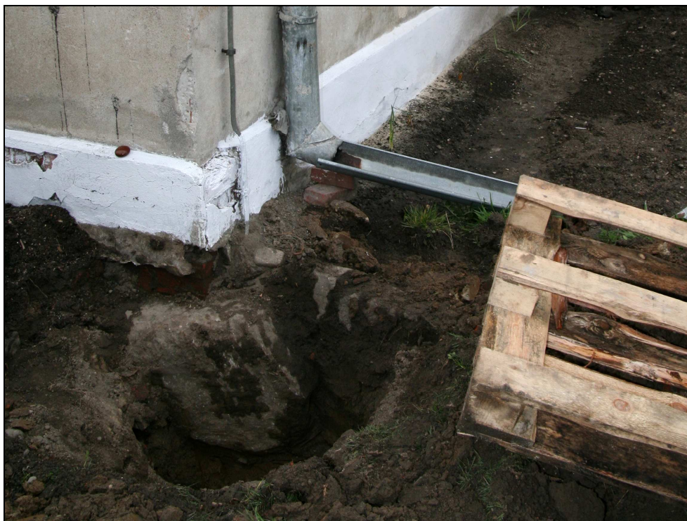
Odkrywka nr 7 – zdjęcie nr 8
