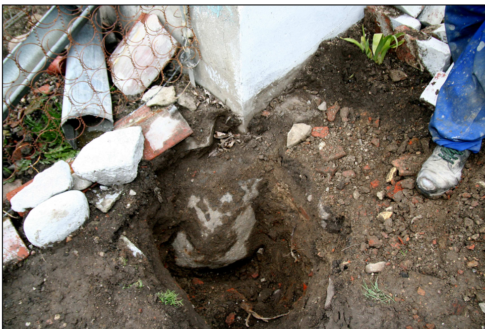
Odkrywka nr 8 – zdjęcie nr 9
