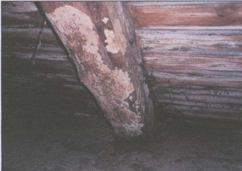
Zaschnięta grzybnia – prawdopodobnie grzyb składowy wywołujący płytki rozkład drewna. Oznaczenie niepewne z uwagi na brak innych śladów – rozwiniętych form grzybni.
