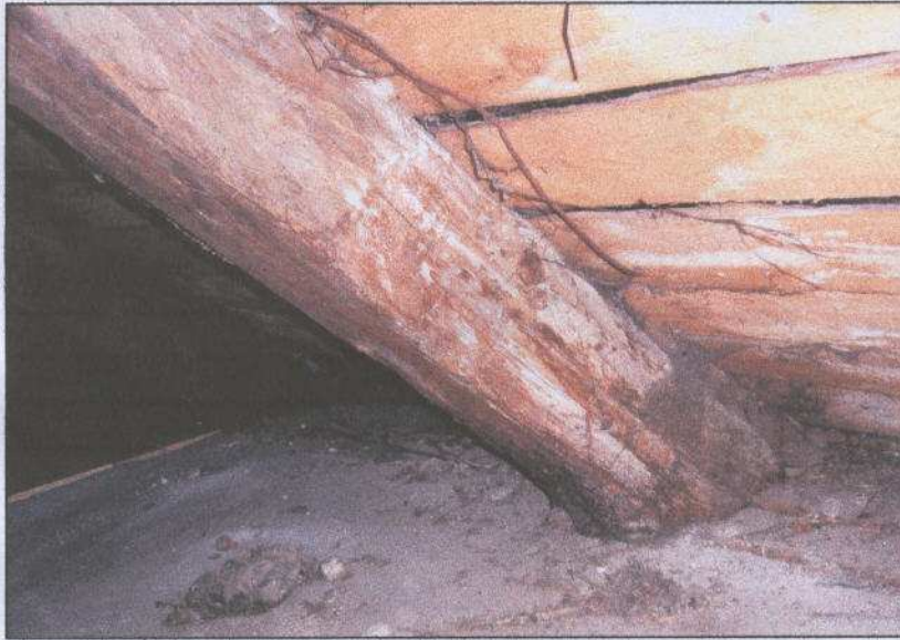
Krokiew z licznymi kanałami owadzimi.
