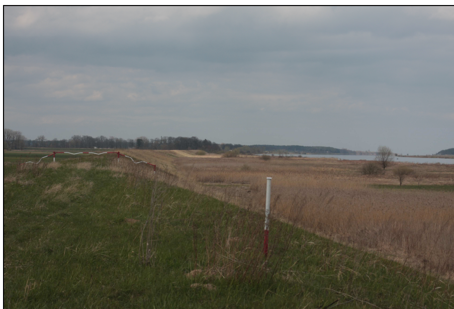
Fot. 1. Fragment lewego wału i zawala w rejonie Przegaliny(zadanie B06). Widok w kierunku północnym (M. Kiejzik-Głowińska, kwiecień 2010)
