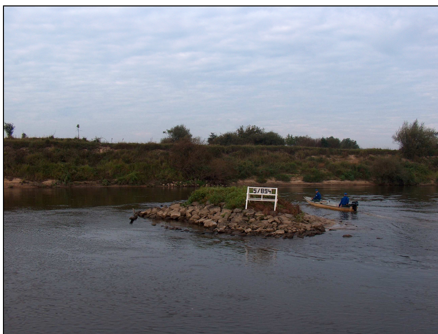
Fot. 4. Erozja brzegu w miejscu zniszczonej ostrogi 5/894
