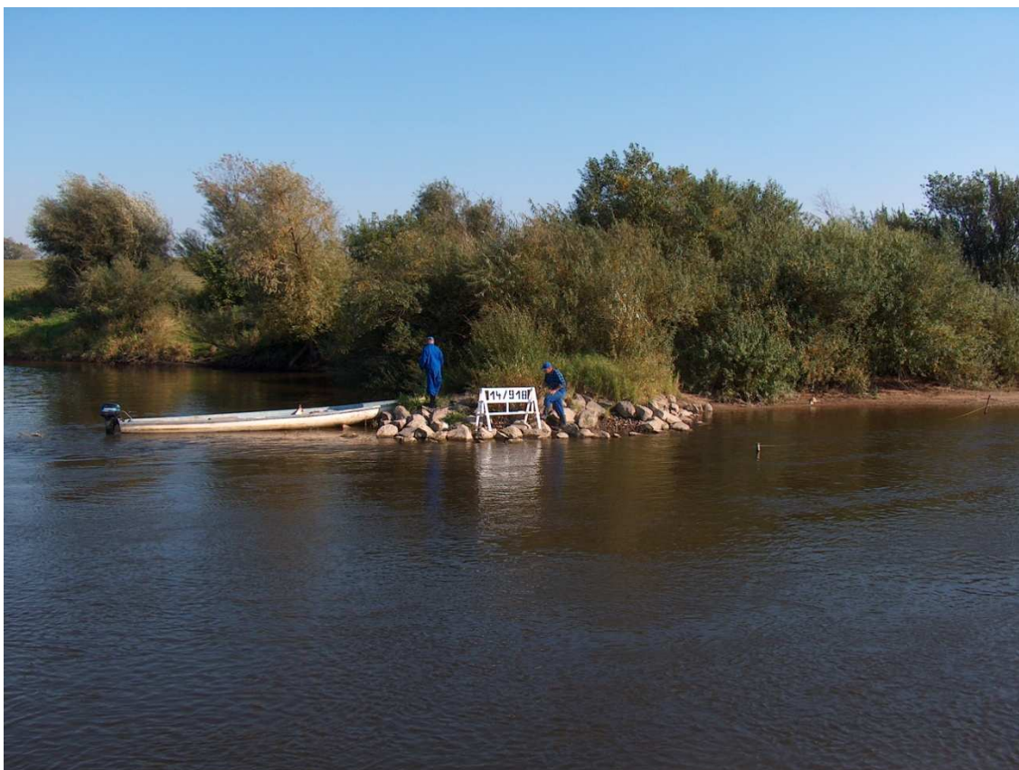
Fot. 25. Ostroga nr 14/918 – gmina Ostaszewo Źródło: RZGW
