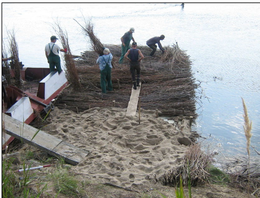
Fot.5. Remont ostrogi (fot. RZGW Gdańsk)
