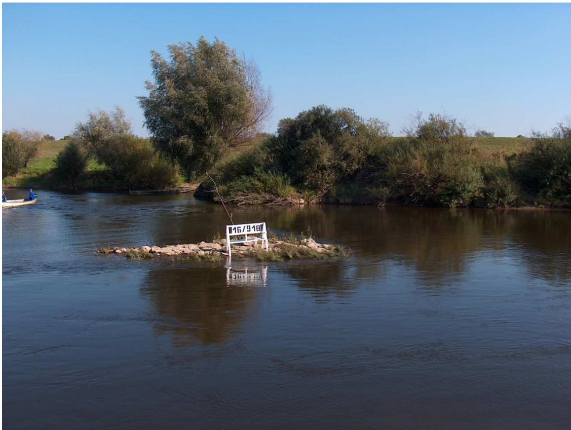
Fot. 26. Ostroga nr 16/918 – gmina Ostaszewo Źródło: RZGW
