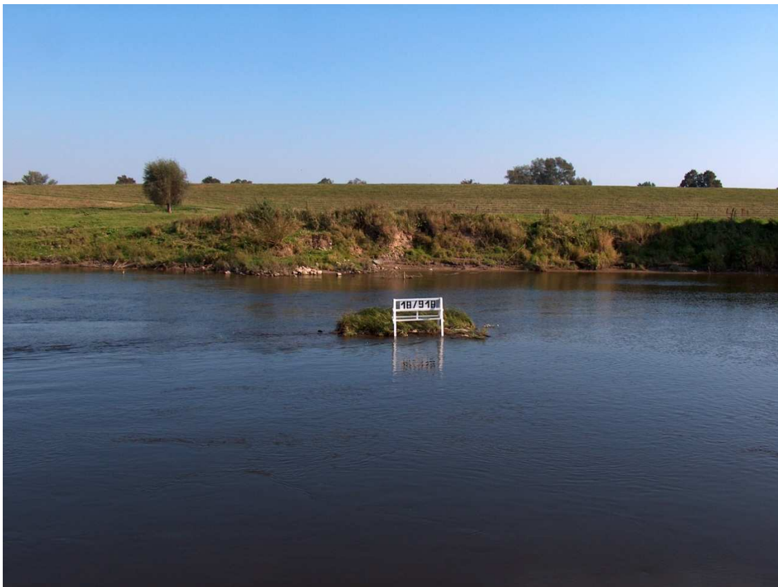
Fot. 27. Ostroga nr 18/918 – gmina Ostaszewo Źródło: RZGW
