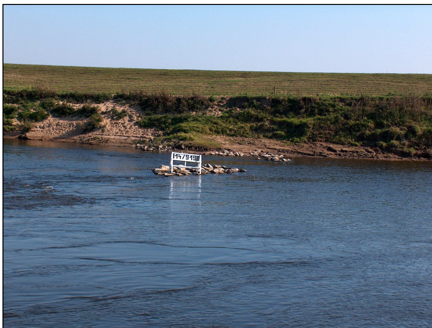
Fot. 3. Erozja brzegu w miejscu zniszczonej ostrogi 14/919
