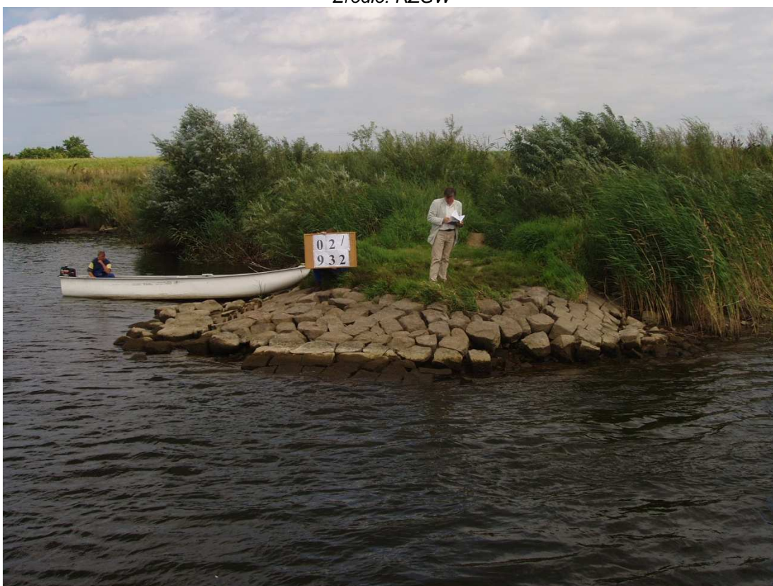
Fot. 30. Ostroga nr 2/932 – gmina Stegna Źródło: RZGW
