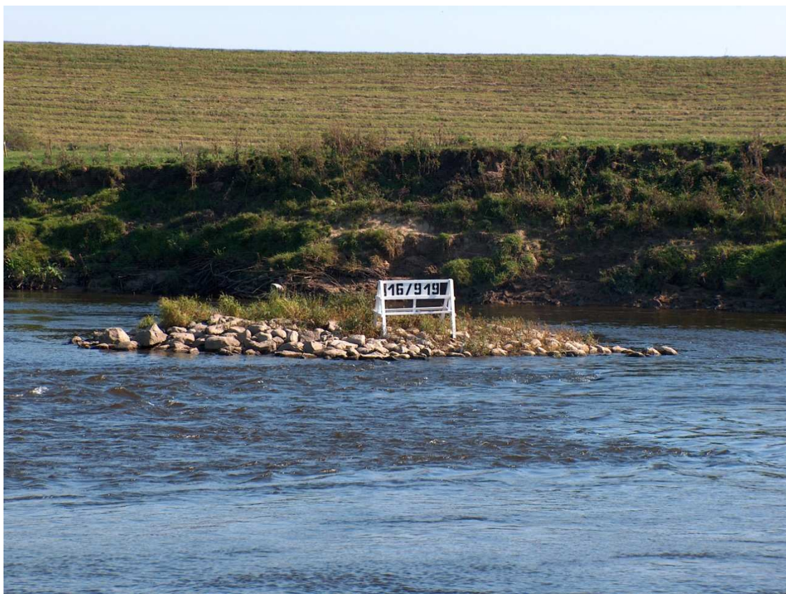
Fot. 29. Ostroga nr 16/919 – gmina Ostaszewo Źródło: RZGW
