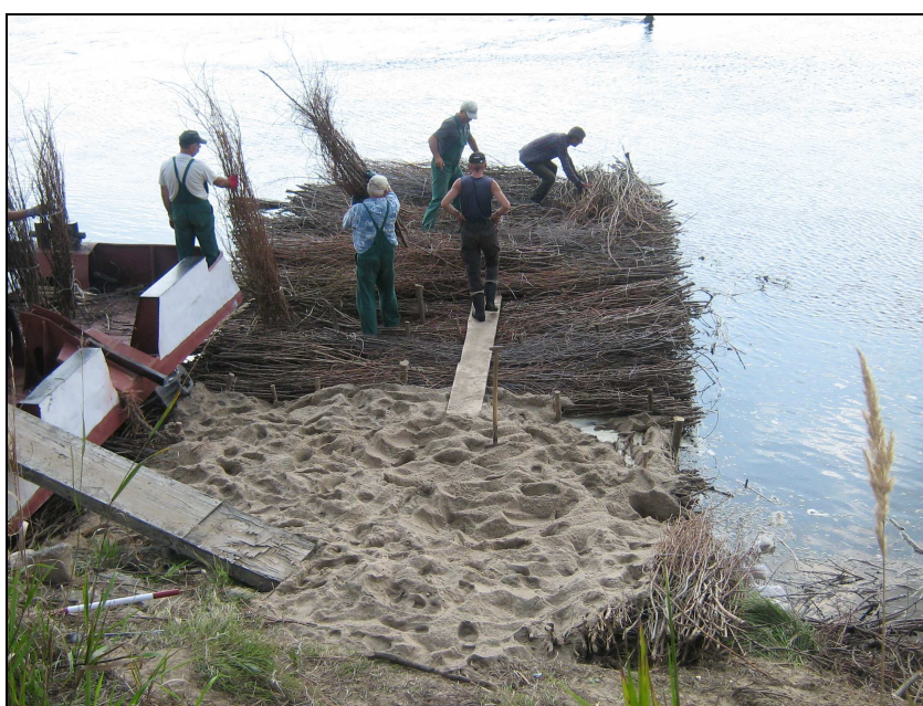
Fot.01. Remont ostrogi (fot. RZGW Gdańsk)
