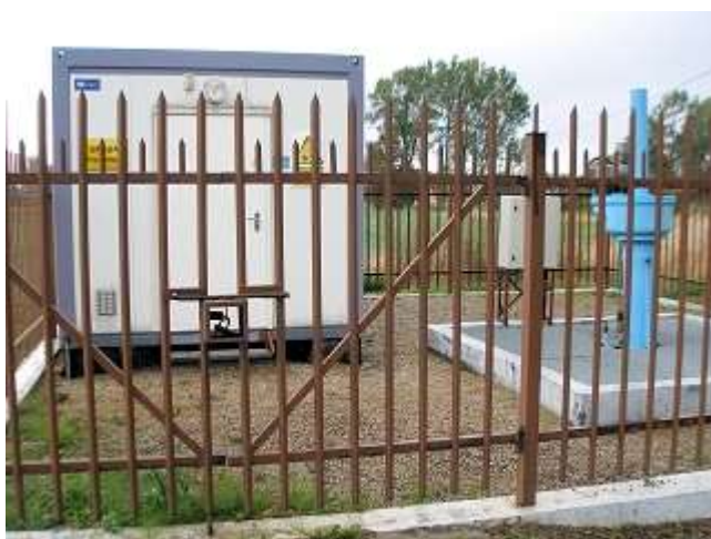
Zdjęcie 12. Stacja zasuw i komputerowego systemu nadzoru wykrywania nieszczelności rurociągów przesyłowych produktów naftowych w Trutnowy
