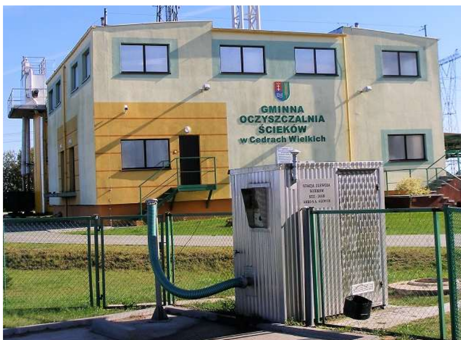
Zdjęcie 6. Punkt zlewny dowożonych ścieków na terenie oczyszczalni w Cedrach Wielkich
