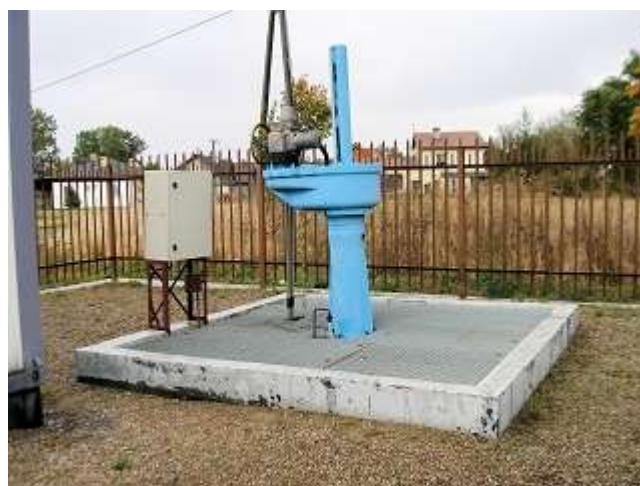
Zdjęcie 12. Stacja zasuw i komputerowego systemu nadzoru wykrywania nieszczelności rurociągów przesyłowych produktów naftowych w Trutnowy
