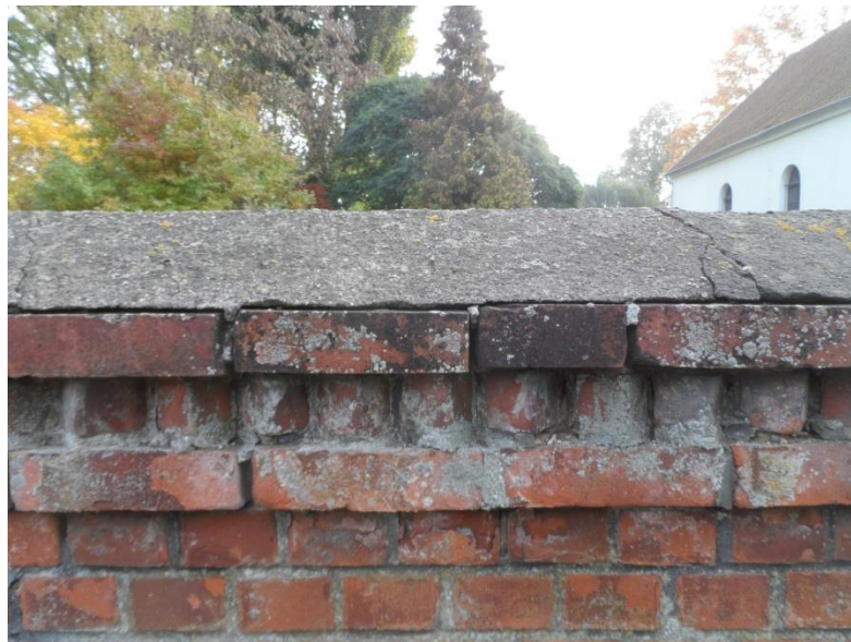
Górna część przęsła ogrodzenia
