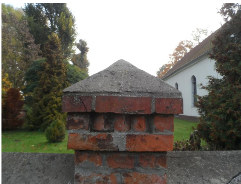
Głowica słupka przęsłowego z czapką betonową
