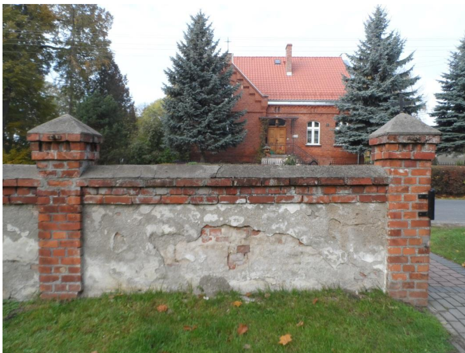
Widok typowego przęsła od strony wewnętrznej
