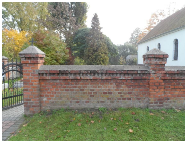
Widok typowego przęsła ogrodzenia od strony zewnętrznej
