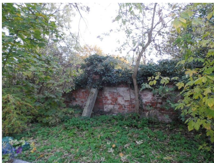
Odcinek południowy, słupek przęsłowy podparty słupem betonowym
