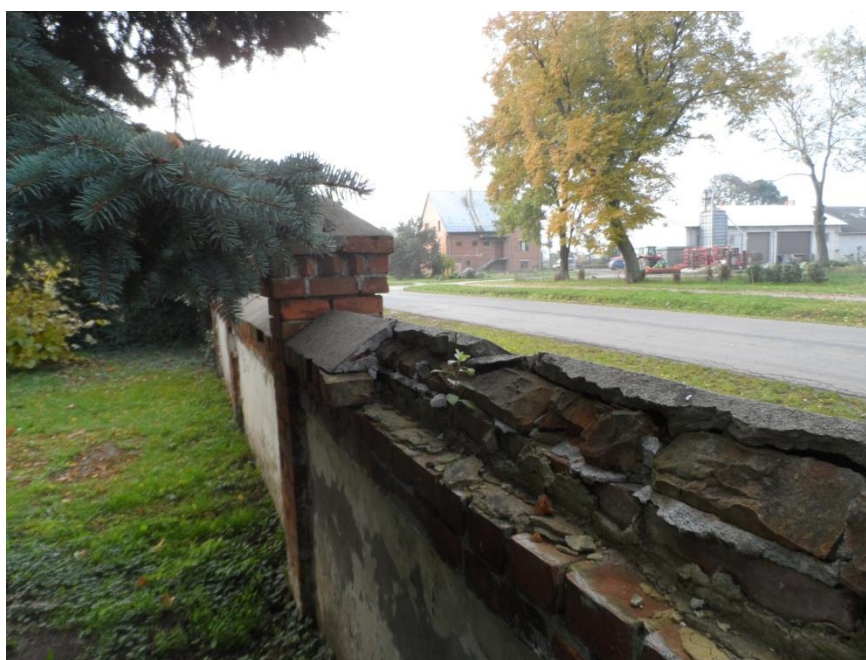
Czapa na przęśle części zachodniej ogrodzenia
