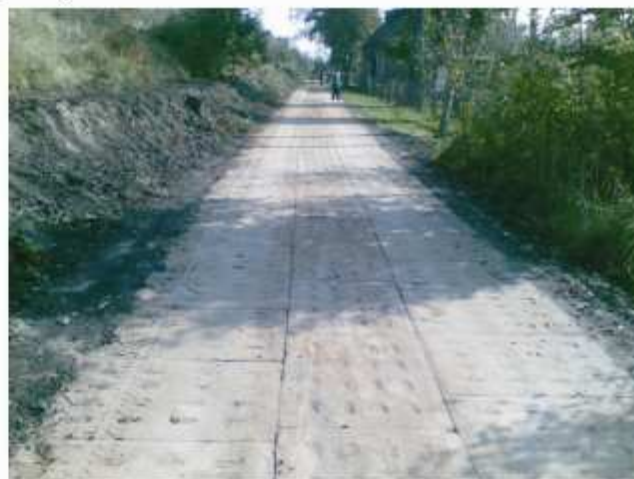
Na zdjęciu: Fragment zmodernizowanej drogi w Trzcinišku
